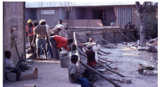
Les travaux de la nouvelle Pédiatrie, dirigés par F.F. (1982)
